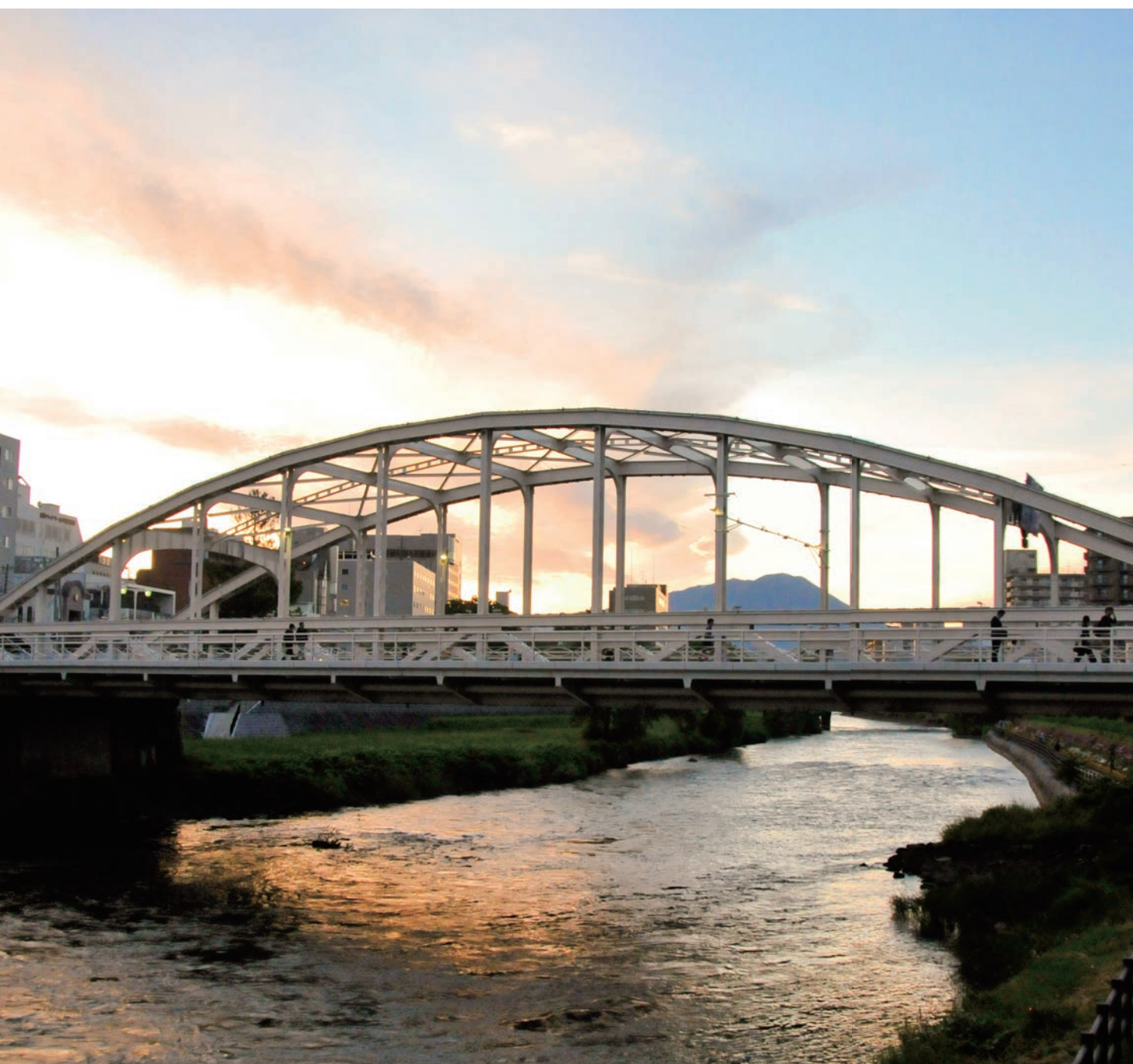
開運橋（盛岡市）
